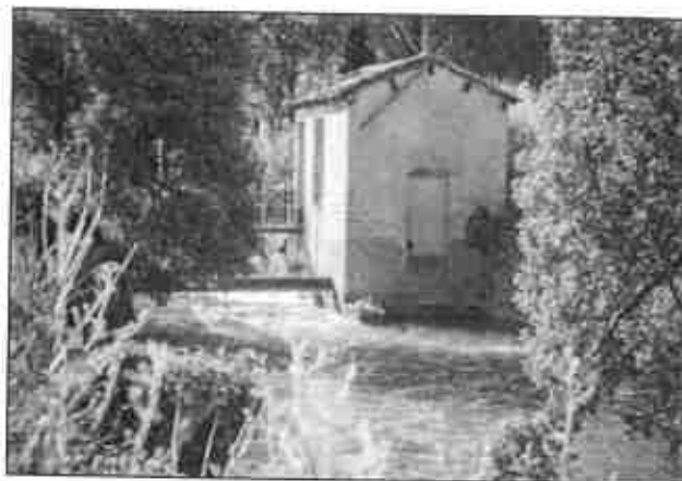
Figure 26 : La turbine du canal Crillon
