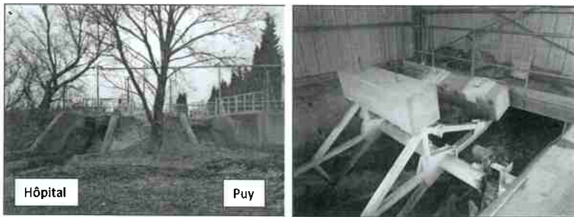
Figure 7 : Bassin de partage de Chatebrun et vanne de décharge (AMIL) en Durance
