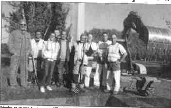
L'équipe en charge des travaux, a été constituée des agents de l'Asa, du conseil général de Vaucluse et de la mairie d'Avignon.
